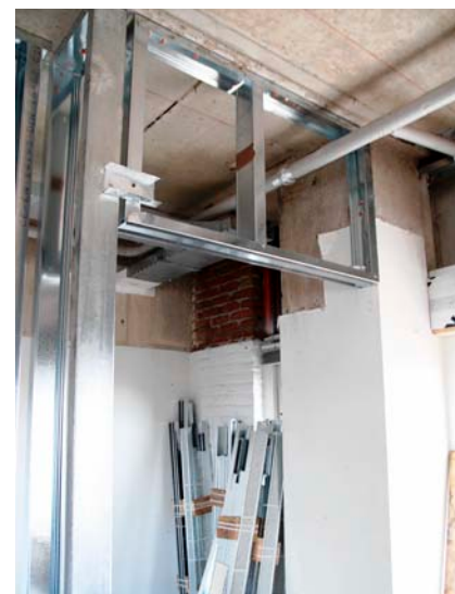
Ook de metaalprofielen worden prefab aangeleverd.
