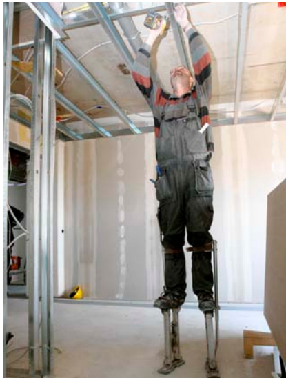
Op stellen voor de plafonds. (Foto: Mat Afbouw)
