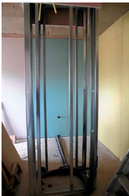
Ook het gips voor de verticale leidingkoker is maatwerk.
